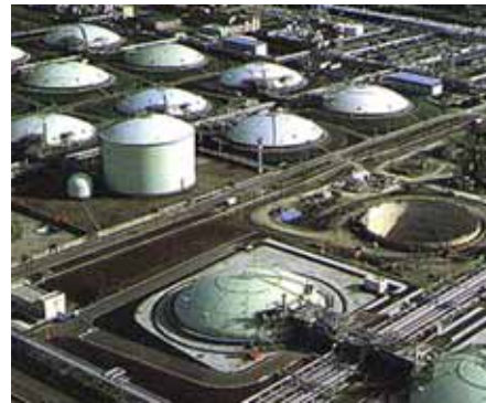
Sodegaura factory LNG tank, BJapan
